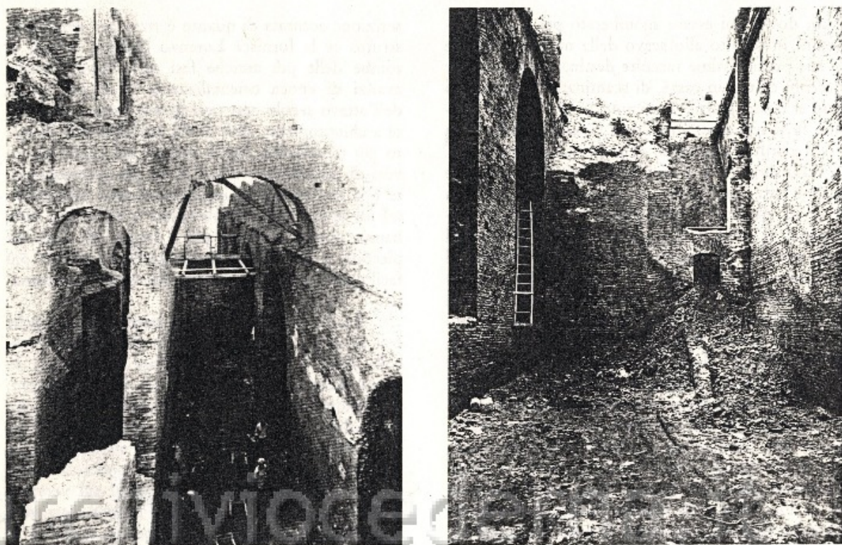
Figg. 95-97 - Lo svuotamento dell'intercapedine alle spalle della basilica di Massenzio.
