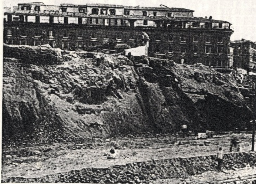
Figg. 88-90 - 1 "vecchi calcestruzzi romani" in corso di demolizione lungo via del Colosseo.
