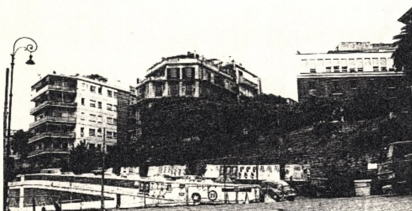
Fig. 121 - La pendice terminale dell'Oppio, ancora non manomessa ripresa dalla copertura della stazione della Metropolitana.
