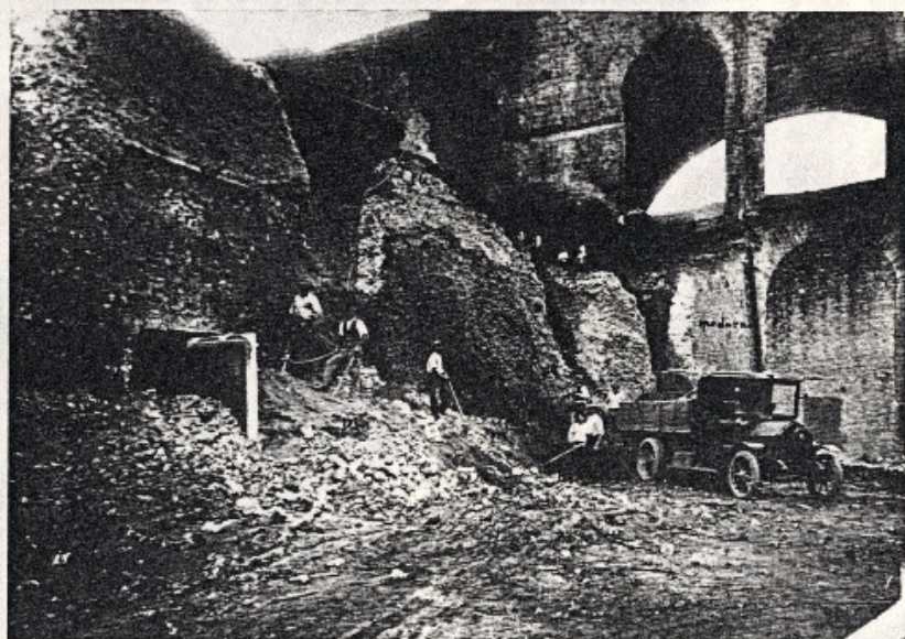
Figg. 91-92 - Le demolizioni alle spalle della basilica di Massenzio.
