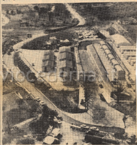
Gibellina (Trapani): un centro residenziale costruito dall'Inr per i sinistralati del terremoto. E' prefabbricati in acciaio, ed è già stato consegnato alle autorità di governo. Frontalmente dello strutto dal terremoto sono state estratte ieri altre quattro salme: il numero dei morti a Gibellina è di 1.400.
