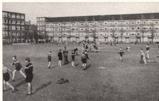
Il verde di vicinato, in un isolato del quartiere occidentale di Geuzenveld. La corte formata dagli edifici a quattro piani è divisa in due parti: una maggiore, a prato alberato; un'altra zona con l'ala per il gioco dei bambini piccoli, vasca di sabbia ecc. *
