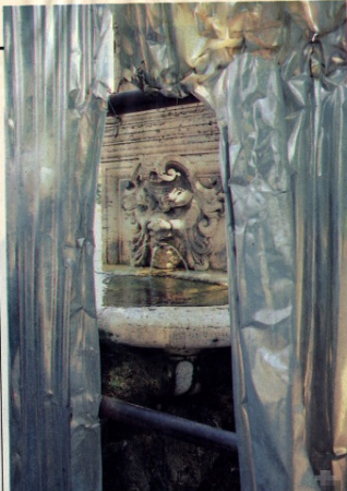
Lavori di restauro alla Galleria Borghese di Roma.
