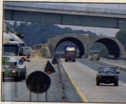
Lavori di ampliamento della rete autostradale italiana
