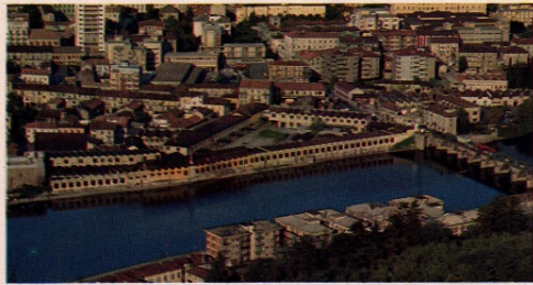
Veduta aerea dei capannoni dell'ex Metallurgica Alodé di Lecco prima della demolizione.
