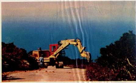
Una ruspa in azione sulla strada di Capelrosso, all'isola del Giglio.
