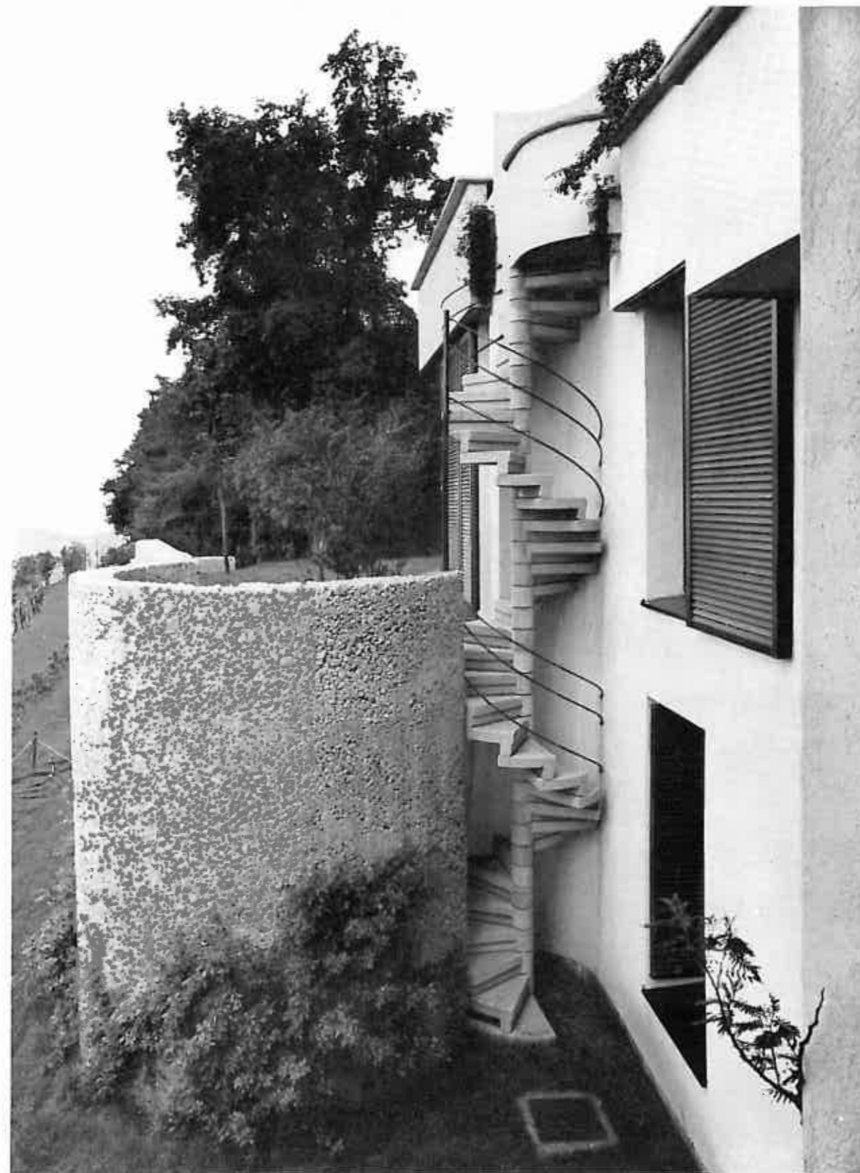
La scala elicoidale che collega le terrazze ai diversi livelli. - Helicoidal stairs connecting terraces at various levels.
