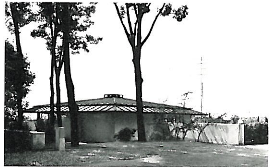
L'ingresso sul fronte Nord. - Entrance on north elevation.
