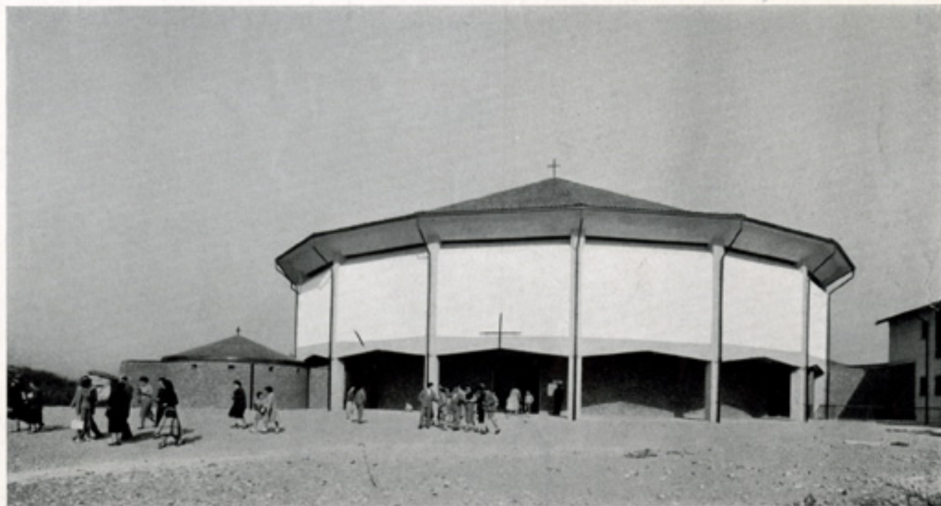
Chiesa di Santa Maria Nascente (1955). Architetti Lodovico Magistretti e Mario Tedeschi, Milano.
