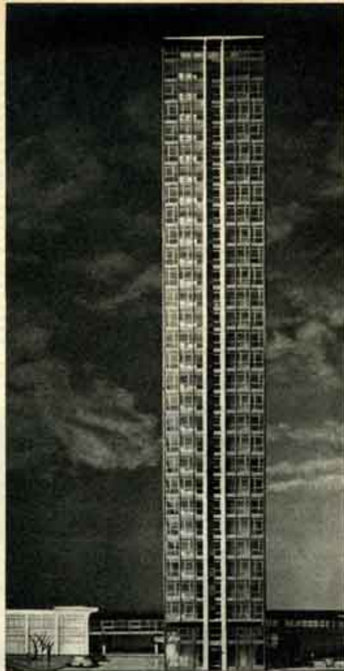
Il grattacielo della Sarom, dovuto all'architetto Melchiorre Bega, apparirà come un grande cubo completamente in cristallo alto 102 metri. I piani sono costruiti su mensole a sbalzo.
